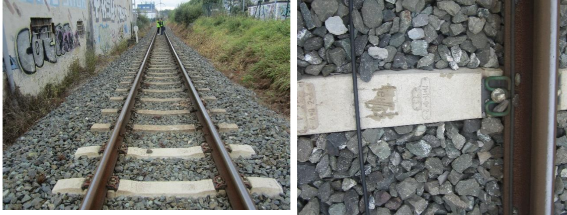
SUPERESTRUCTURA DE VÍA EN EL INICIO DEL TRAMO
